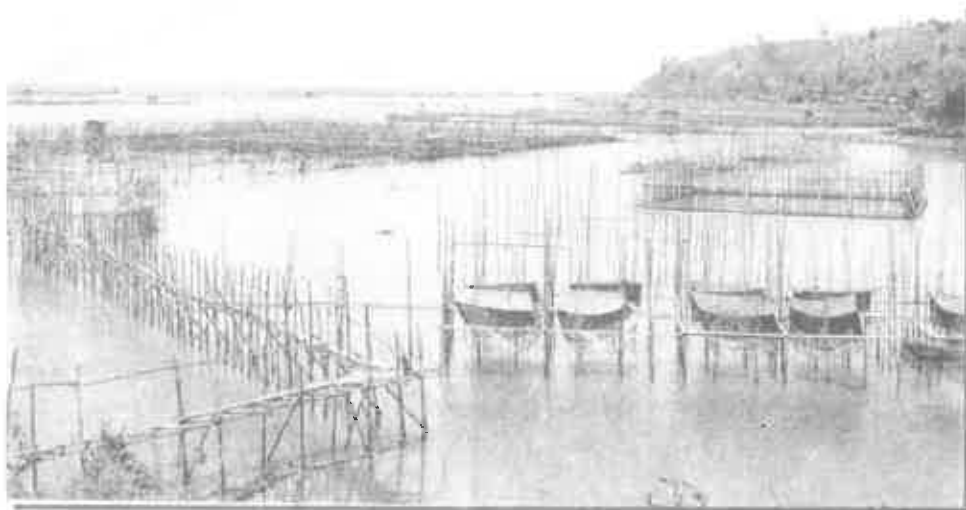
شکل ۲: قفسهای ثابت جهت پرورش ماهیان گرمسیری در آسیای جنوب شرقی (Cage Aquaculture, 1996)
